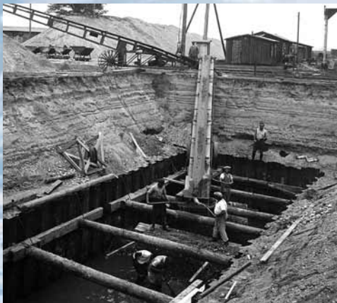
Arbeiten an der Rheinbrücke Krefeld-Uerdingen, 1935
