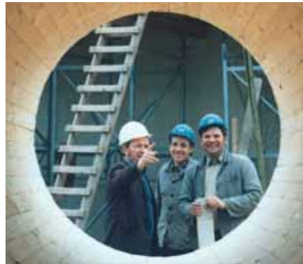
Inspektion einer Stützenschalung, 1977
