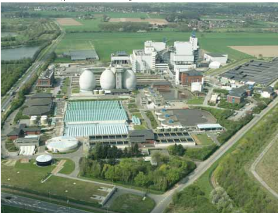
EAG Entsorgungsanlagengesellschaft, Krefeld
