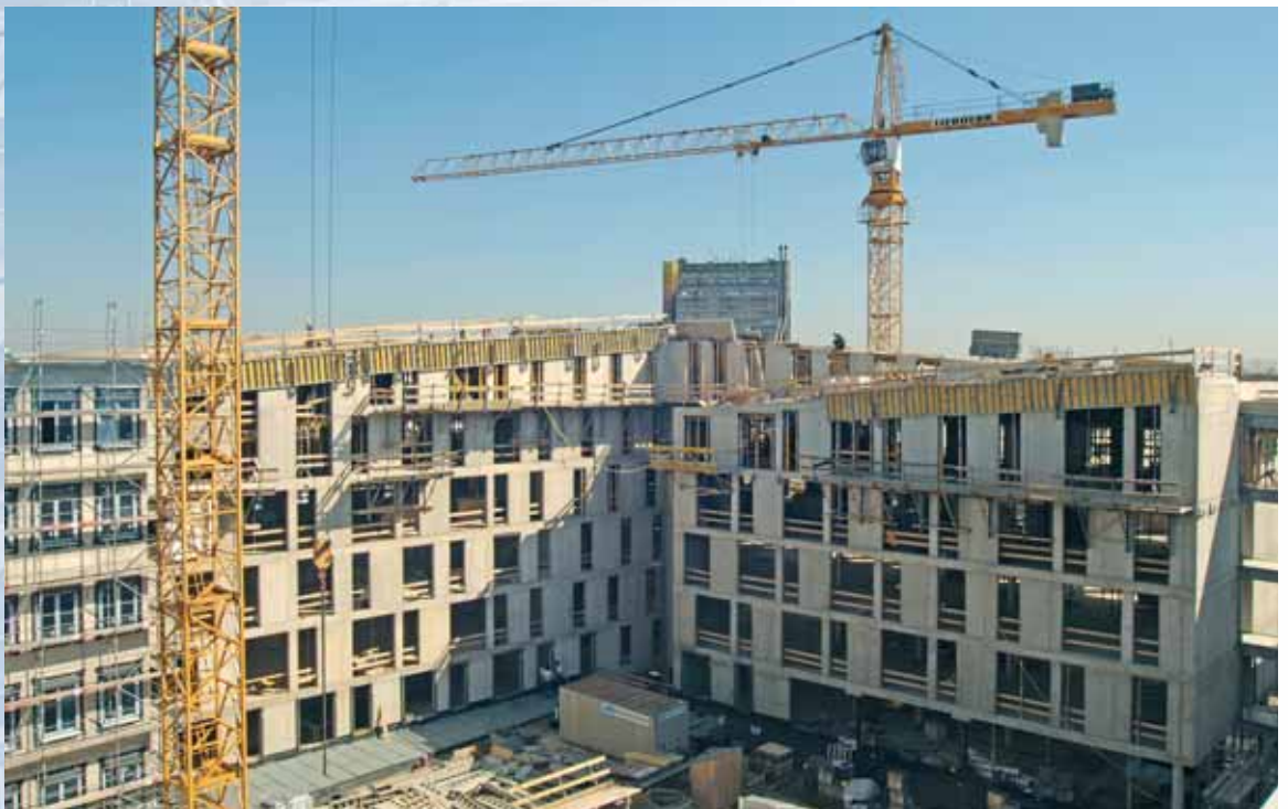
Bauvorhaben Rheinstraße, Sparkasse/WZ Krefeld
